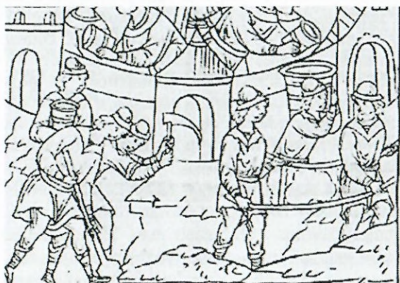
На рис. показана работа по возведению оборонительных стен и земляного вала: лопата, кирка, носилки и плетеная корзина. Л.Л.С. XVI в.
