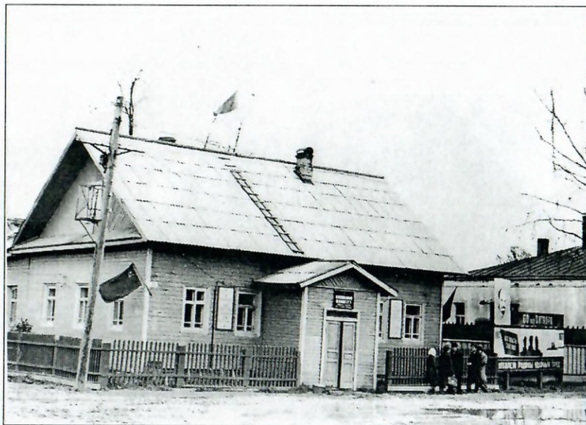
Здание на углу улиц Ленина и Красная. Фото 1977 г Райсполком, затем Сберкасса, затем Отдел молодежи. Здание разобрано в 2014 г.
