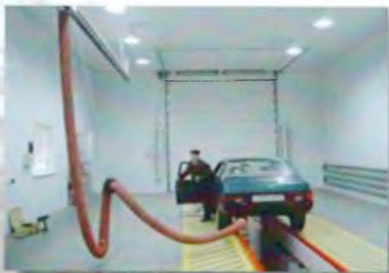
Станция технического обслуживания ИП Горынцев В.Г.
