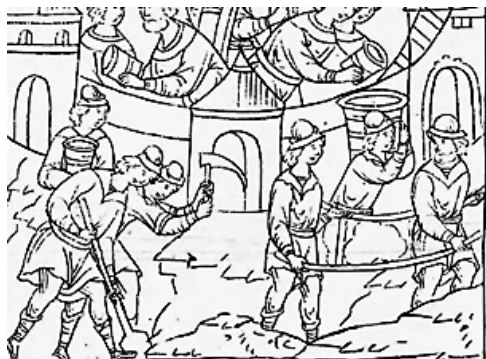
На рис. показана работа по возведению оборонительных стен и земляного вала: лопата, кирка, носилки и плетеная корзина. Л.Л.С. XVI в.
