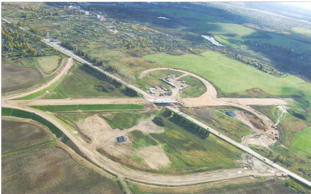
А так выглядел обход Вологды в начале XXI века в период строительства.
