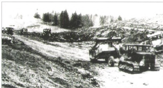
Начало строительства автодороги Чекишино - Тотьма - Никольск.
