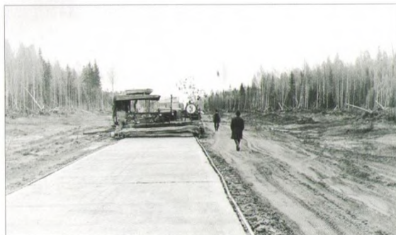
Строительство цементобетонной дороги на Ленинград, 70-80-е годы XX века.
