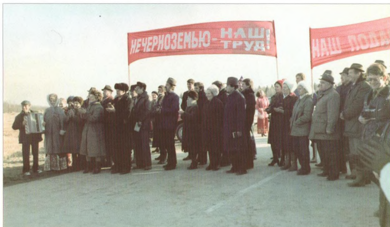
В ожидании торжественного момента сдачи очередного участка автодороги.
