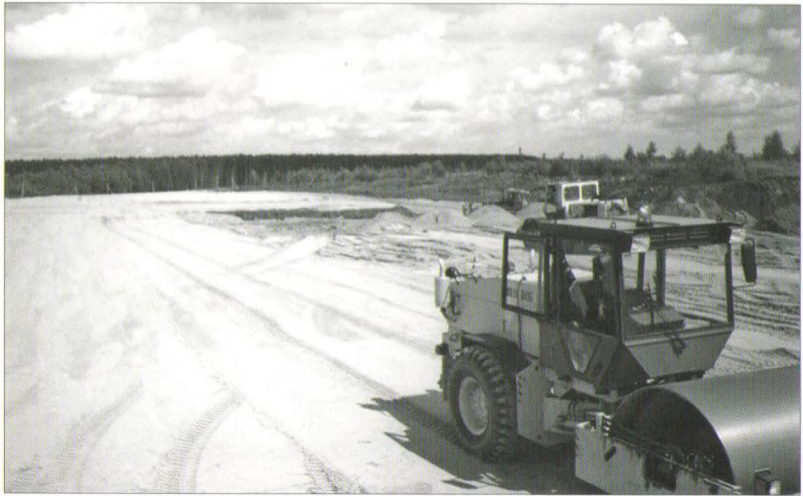
Очертания будущей дороги.
